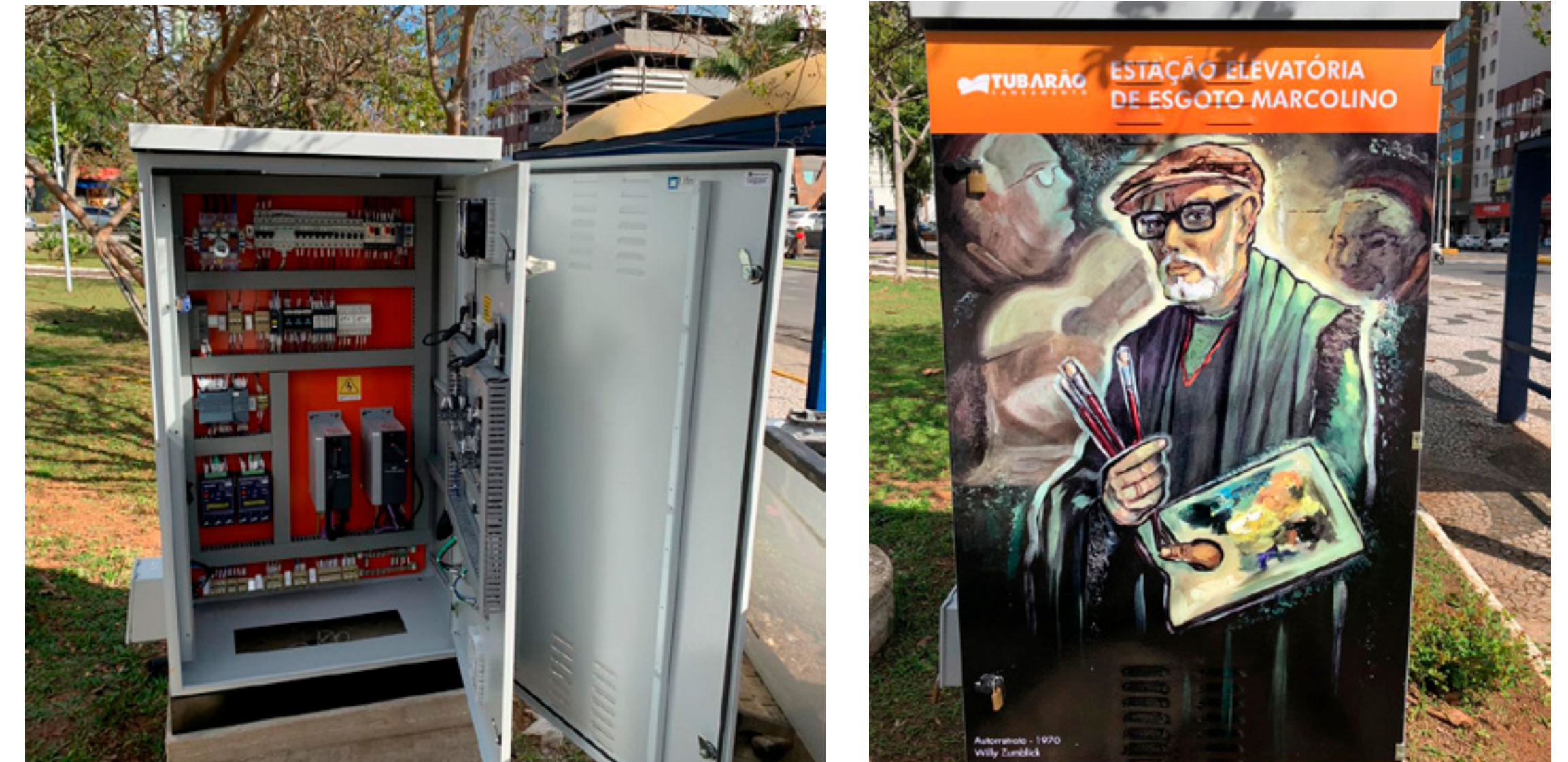
Detalhes da parte interna (à esquerda) e da porta (à direita) do painel de comando da EEE
